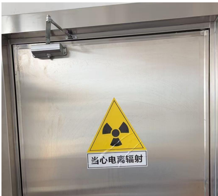
图 3-2 防夹装置和闭门器装置
