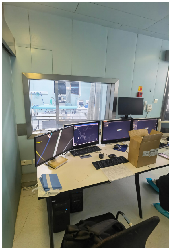
DSA 机房东侧控制室
